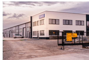
Firma Pelmet – w budowie
