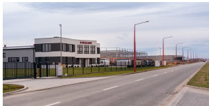
Na pierwszym planie firma MEESE Polska. W oddali hala Agencji Rozwoju Przemysłu- w budowie
