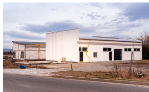
Firmy w budowie – Agencja Reklamowa Media Desing oraz Garden Steel
