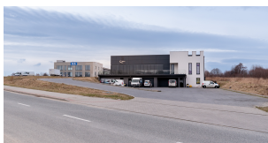
Firmy w Strefie Inwestycyjnej "Krosno- Lotnisko" – na pierwszym planie firma Darlas
